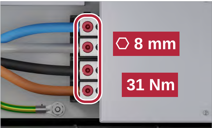
Couples de serrage au niveau du bornier AC
